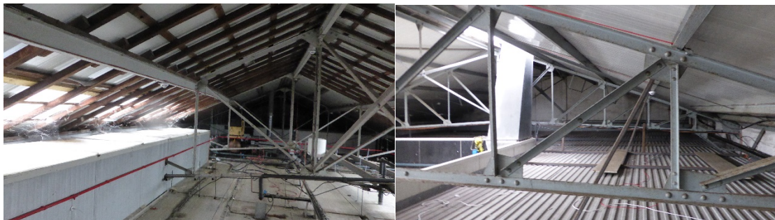
Charpente et toit
